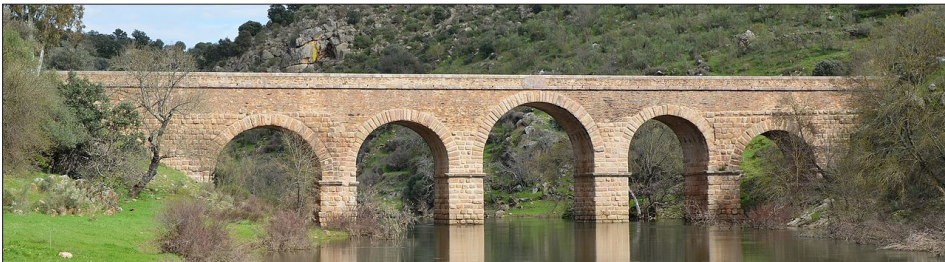
Romerska bron i Segura, Portugal, byggd på 200-talet, med sina för tiden typiska halvcirkelbågar
