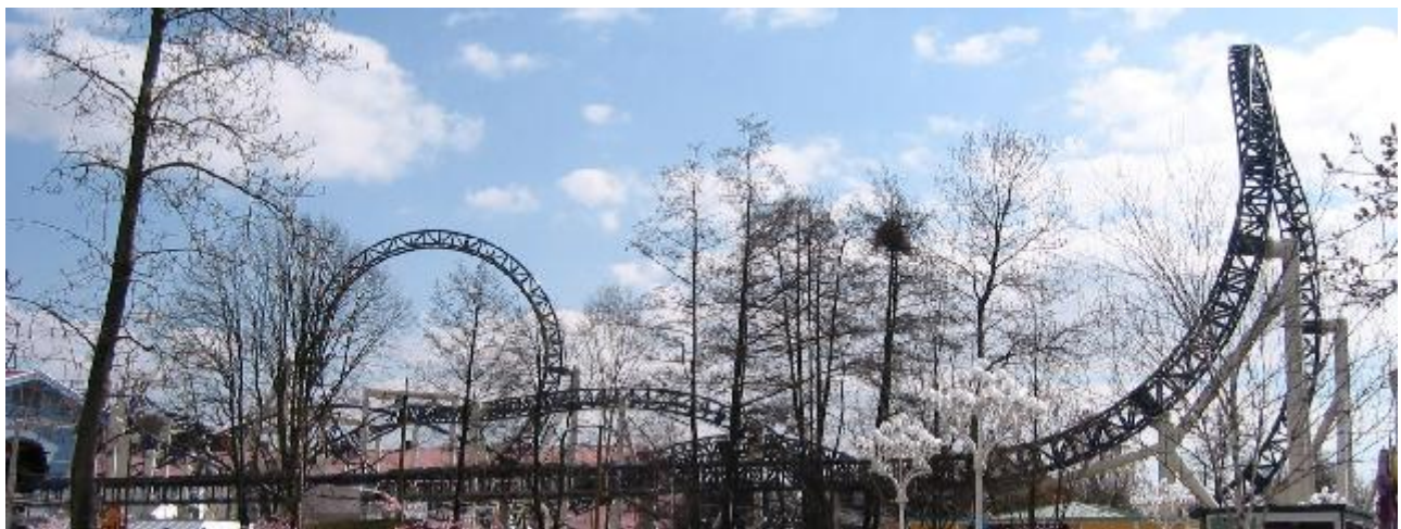
Figur 1: Lisebergs berg- och dalbana Kanonen sedd från sidan. Bilden visar utskjutningen sker från vänster på bilden mot "Top Hat" till höger, och även loopens form.
